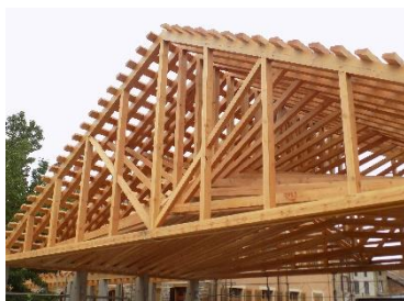
Halle en chantier Lamure S/Azergues
